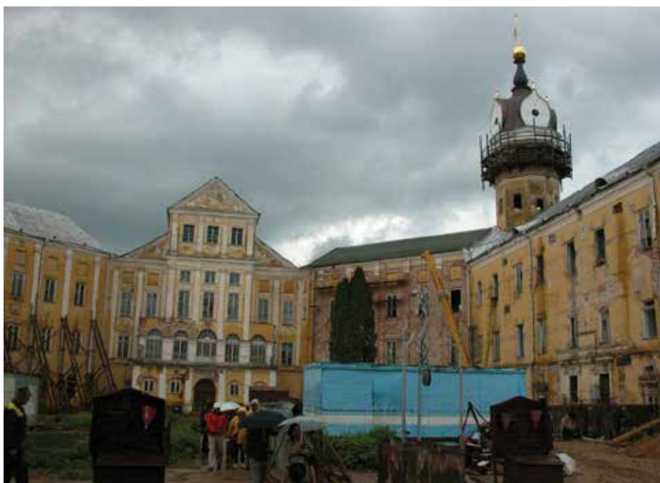
Zamek w Nieświeżu w trakcie konserwacji
